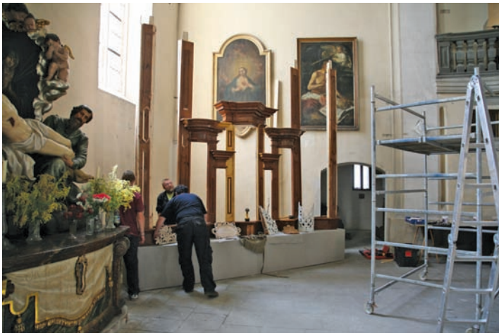
Postupné sestavování nosné konstrukce prospektu
