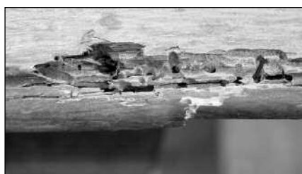
Destrukce skříň pozitivu, 2005
