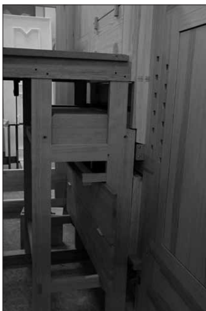
Nosná konstrukce hracího stolu z masivního dubu uvnitř skříně
