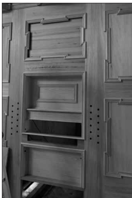
Postament varhan s otvory pro instalaci varhanního stolu
