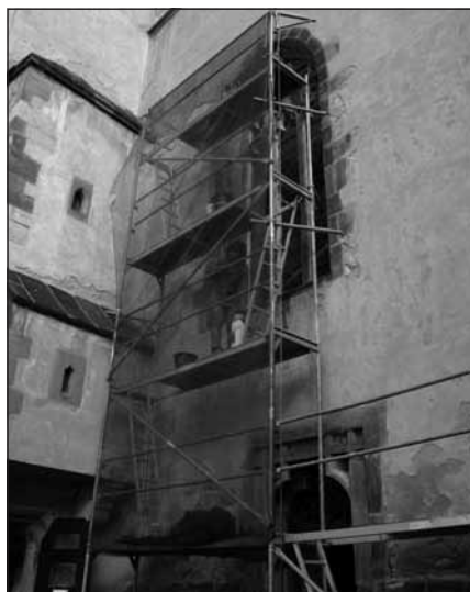
Restaurování okna v západním průčelí, 29. 10. 2013
